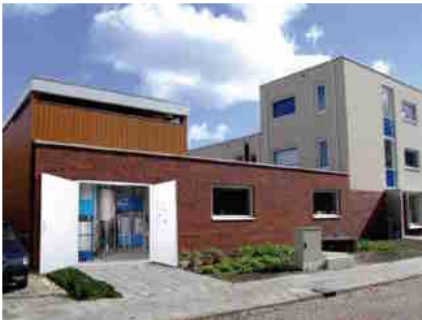
Figuur 8. Collectieve voorziening in Sneek: kelder en garage met installaties voor decentrale waterzuivering en winning van energie en meststoffen (artistieke fotocompilatie). Bron: www.landustrie.nl
